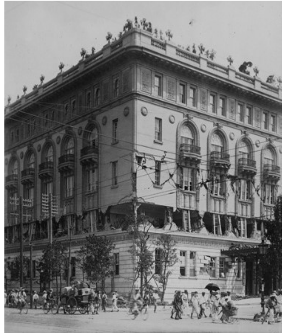
2、3階が被災した 丸の内 東京会館
